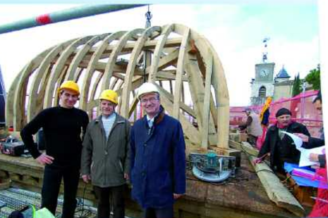
< Visite de chantier du clocher de l'Église : la nouvelle charpente en cours d'installation
