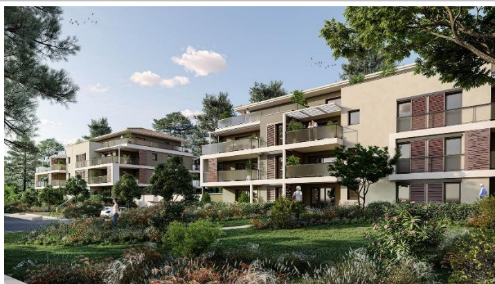
Figure 5 : Exemple d'habitat collectif
