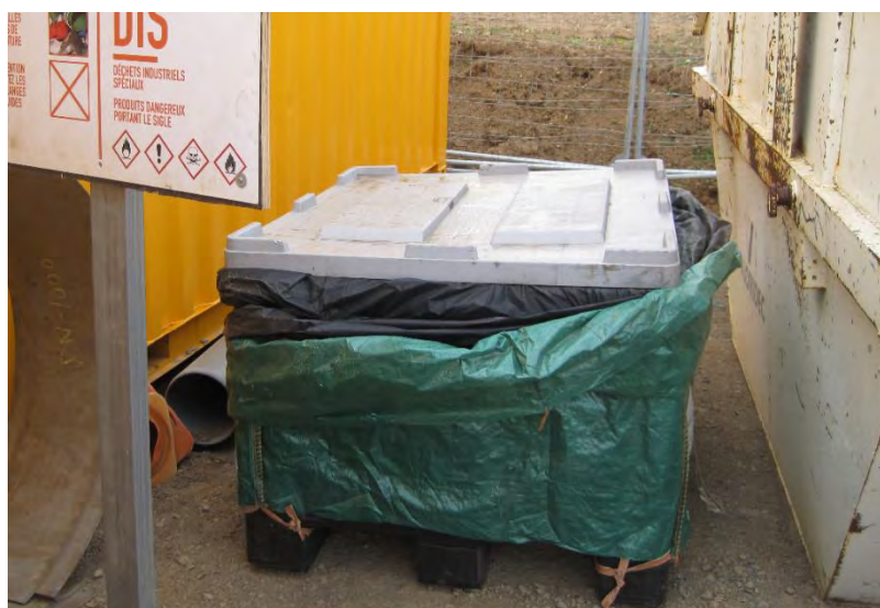
Figure 57 : Exemple de benne fermée pour les déchets dangereux
