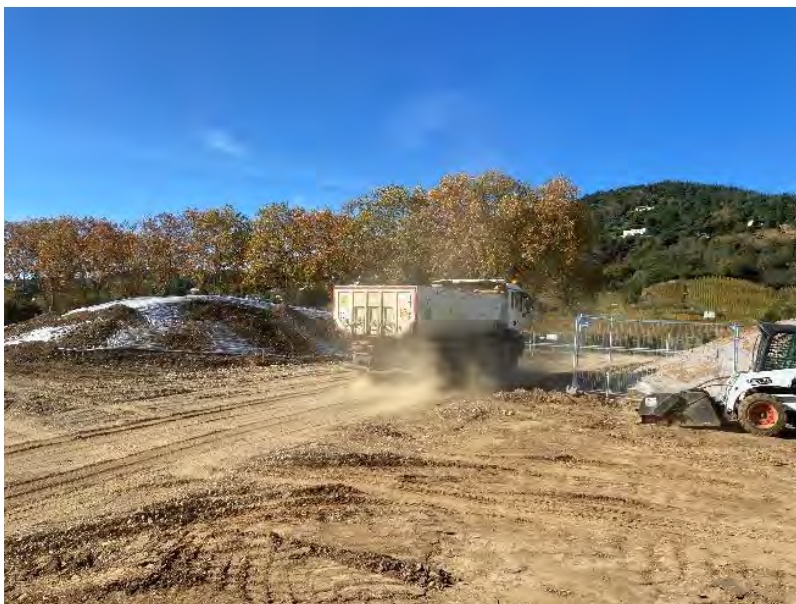
Figure 59 : Exemple de poussière soulevée par le passage d'un engin de chantier
