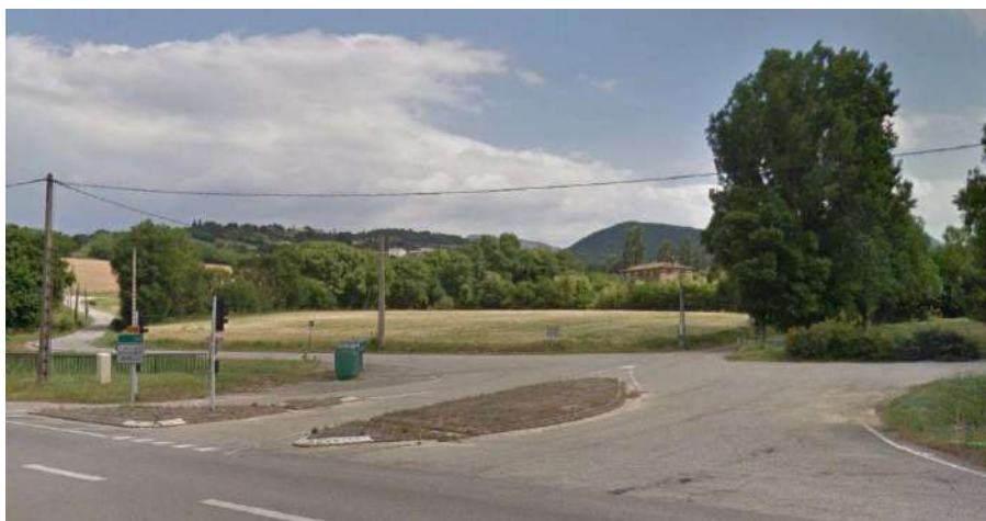
Le carrefour aménagé sur la RD 164
